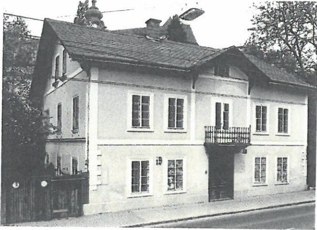
Straßenansicht des gründerzeitlichen Vorstadthauses, 2001
